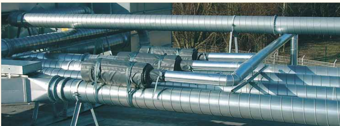
Proteção anticongelamento com sacos isolantes
